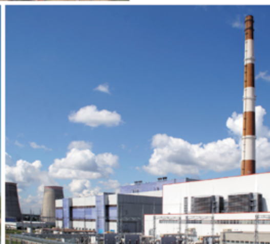
Энергоблок №4 ПГУ-450 ТЭЦ-27
