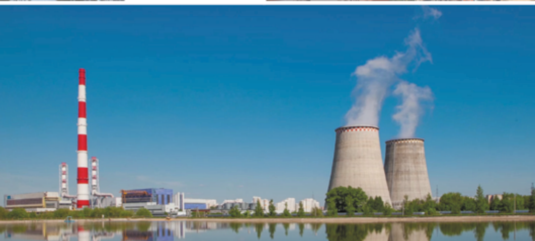
Энергоблок №3 ПГУ-450 ТЭЦ-27
